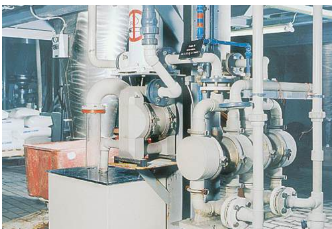
Galwanizernia Pompy membranowe DEPA do osadu
