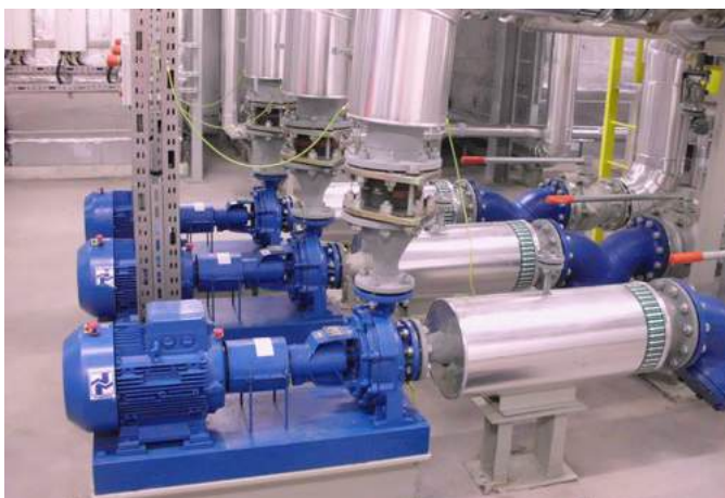
Magazyn gazu ziemnego Pompy wirowe ALLWEILER do wody
